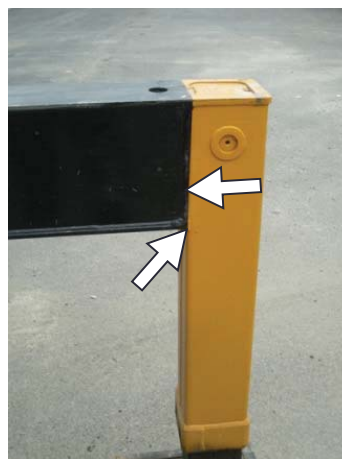
アウトリガの点検・検査箇所
