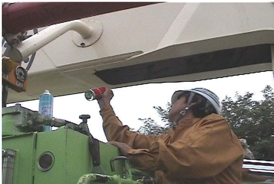
カラーチェック(浸透探傷検査)の様子
