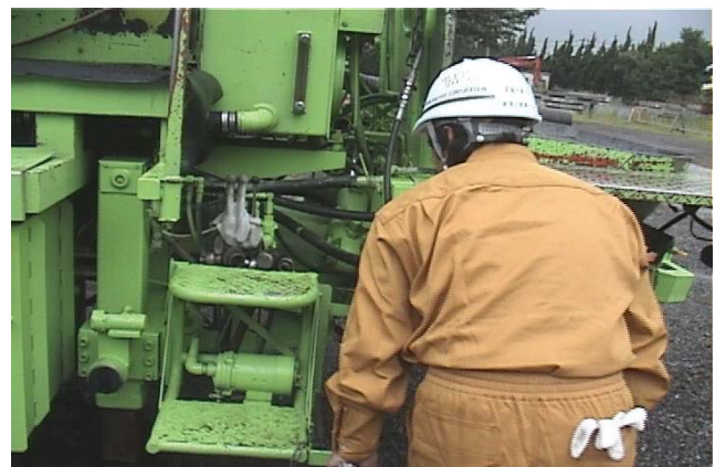
油圧ホース類の点検の様子
