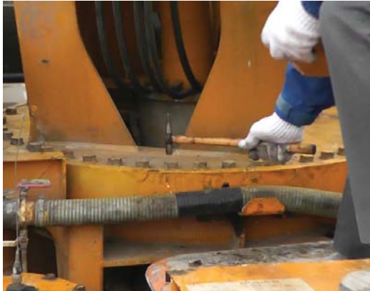
テストハンマーを使用している様子
