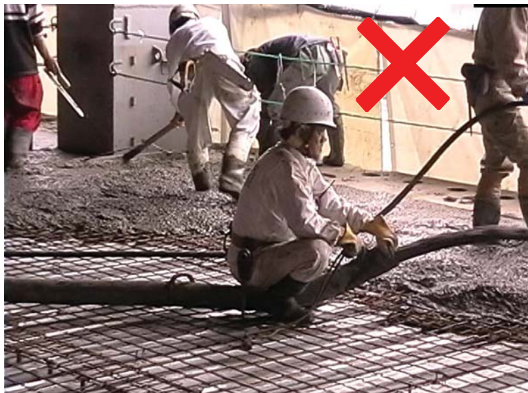
先端ホースの吐出口に手を突っ込んでコンクリートを遠くへ飛ばさない
