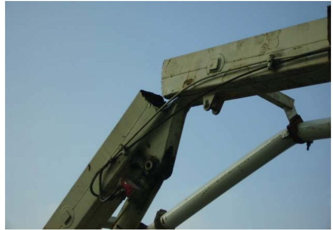
ブーム折損事故の例
