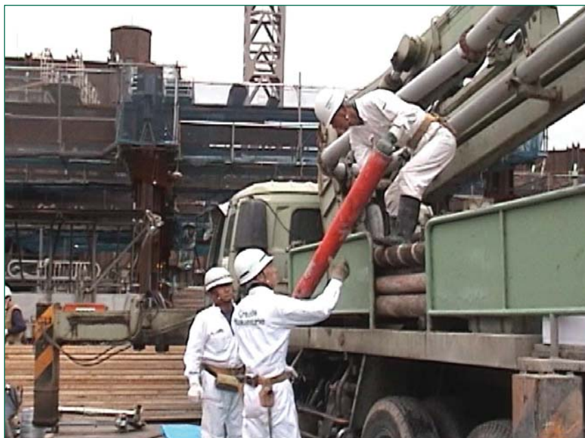
輸送管の積み降ろし作業の様子
