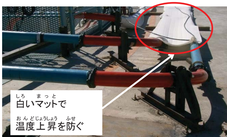
ゆそうかん おんどじょうじょう ふせ ようじょう れい 輸送管の温度上昇を防ぐための養生の例
