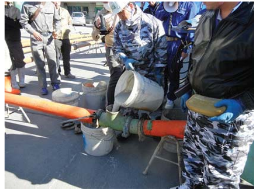
T 字管を使用した先送り材を減らす方法の例
