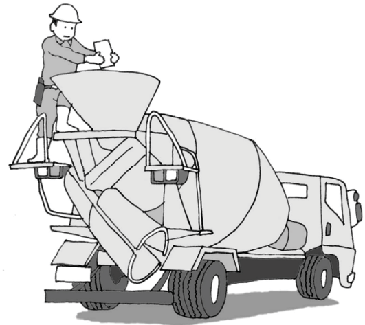
流動化剤を加えている様子
