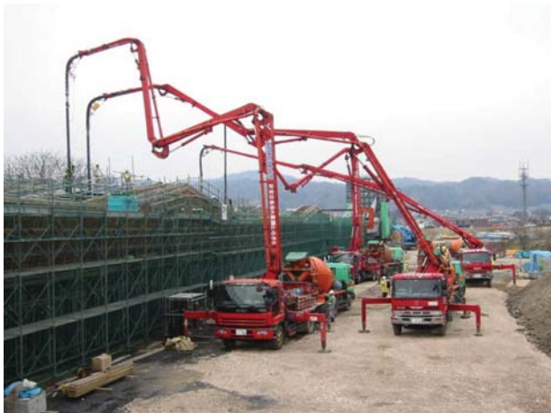
コンクリートポンプ(ブーム車)による 圧送作業の様子
