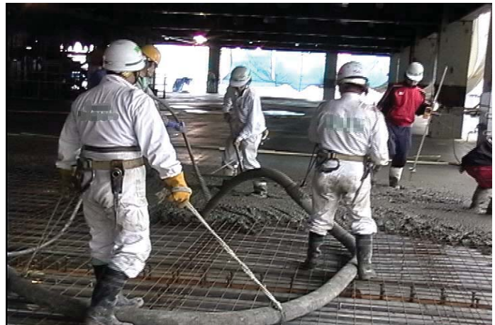
筒先作業(ホースによる配分作業)の様子
